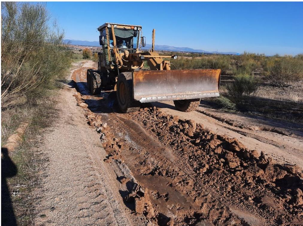
**Figura 15.** Remodelado de pista con motoniveladora y sin aporte de zahorra en la Vereda Segoviana, en Villaviciosa de Odón (Tramo LI260).
