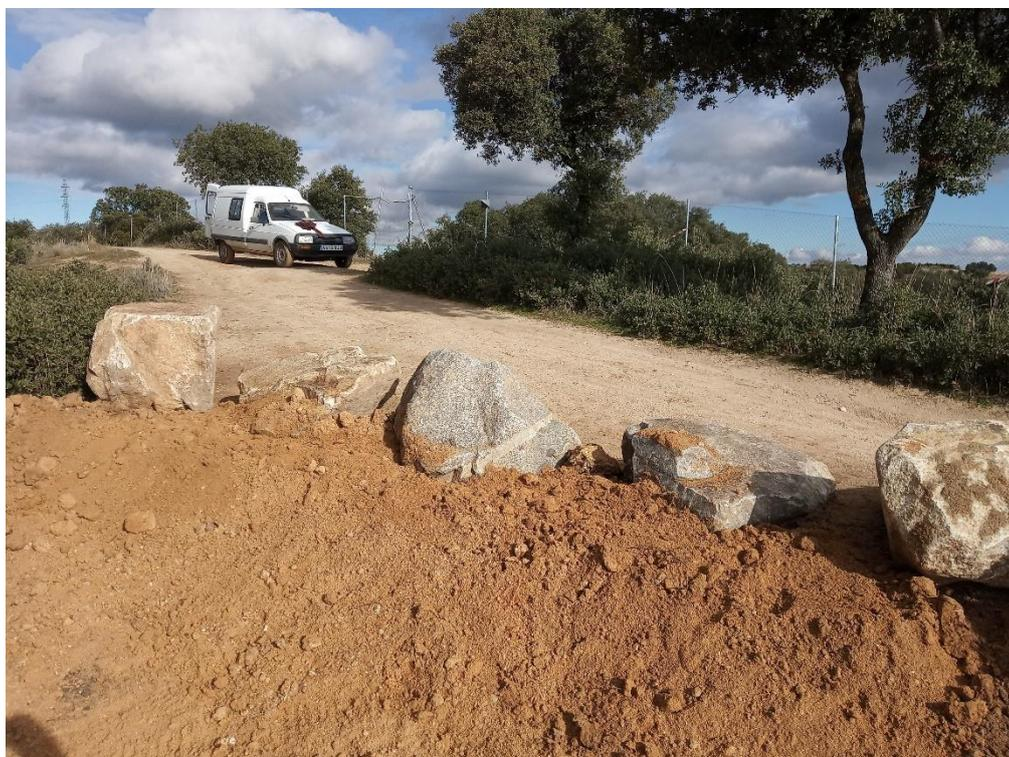
**Figura 9.** Alineación de bloques de piedra en la Vereda de las Tapias de Viñuelas y del Pardo, en Colmenar Viejo (Tramo LI622). En la imagen se aprecia también el resultado de las labores de descompactado y perfilado en el espacio a recuperar (ver *entregable C.3.1*).
