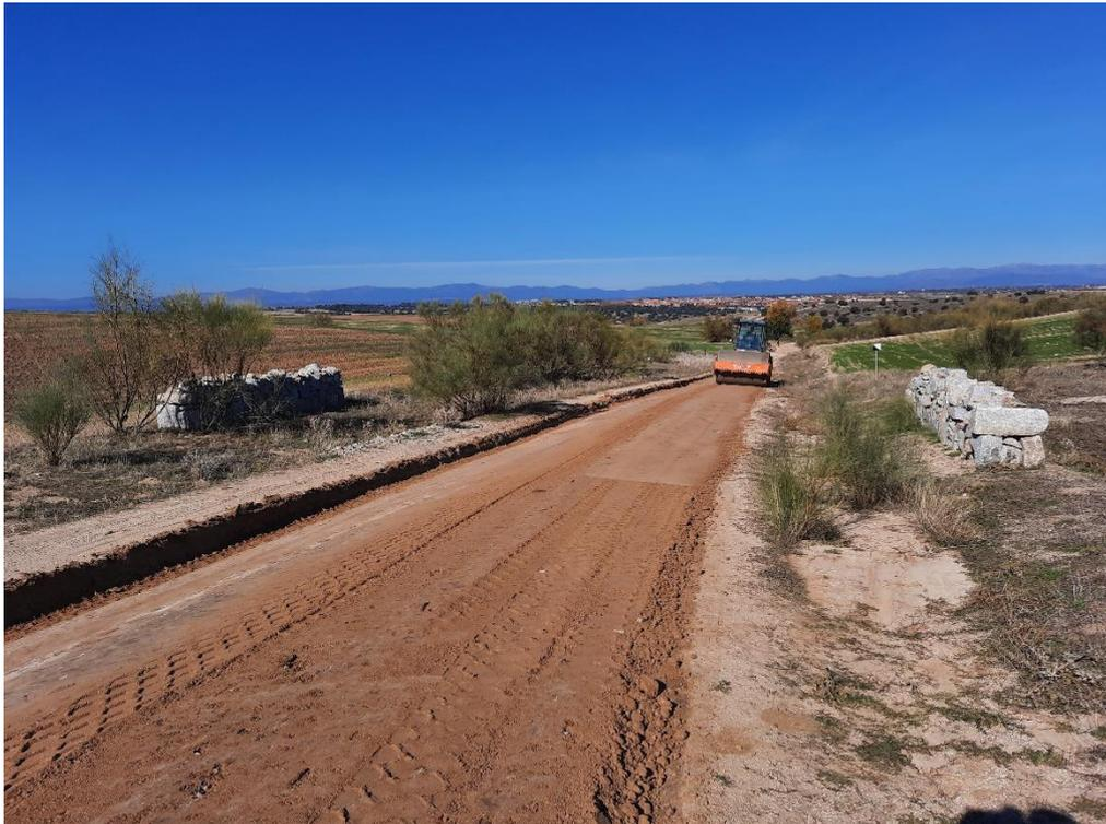
**Figura 16.** Compactado de pista sin zahorra adicional con apisonadora dotada de rodillo en la Vereda Segoviana, en Villaviciosa de Odón (Tramo LI260). En la fotografía se aprecia la reducción de la pista inicial a una anchura de 3m, ampliando así el espacio regenerable para hábitats propios de las vías pecuarias.
