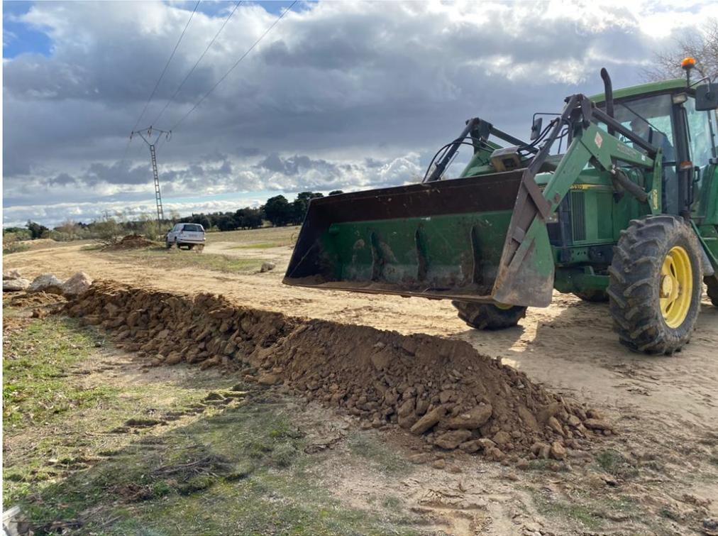
**Figura 6.** Construcción de cordón de tierra para bloqueo del paso de vehículos en la Vereda de Castilla, en Alorcón (Tramo LI213).
