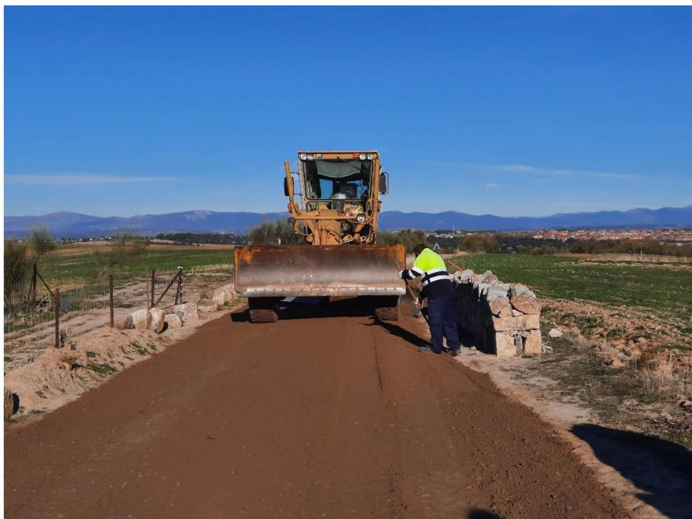
**Figura 13.** Extendido y modelado de zahorra a dos aguas con motoniveladora en la Vereda Segoviana, en Villaviciosa de Odón (Tramo LI260).
