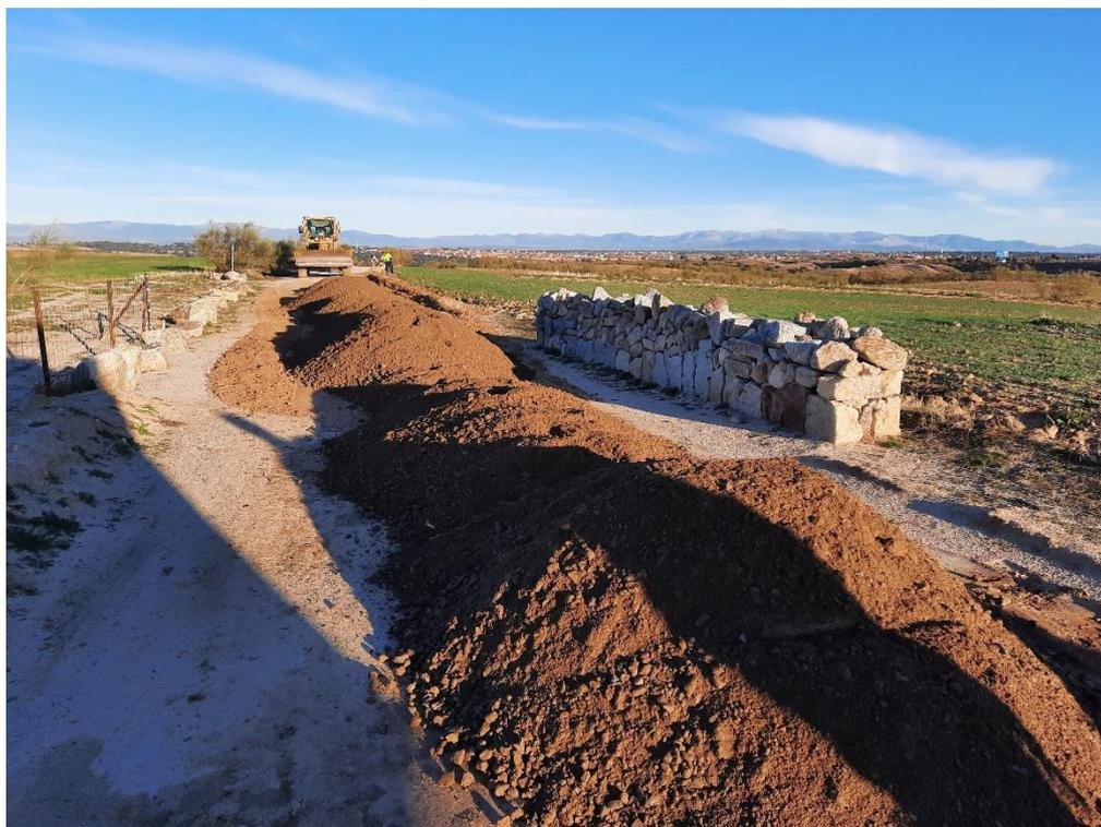
**Figura 12.** Zahorra distribuida y preparada para ser extendida por motoniveladora en la Vereda Segoviana, en Villaviciosa de Odón (Tramo LI260).
