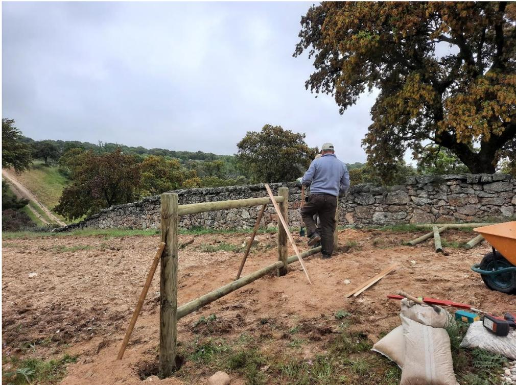
**Figura 10.** Instalación de talanqueras de madera en la Vereda de las Tapias de Viñuelas y del Pardo, en Tres Cantos (Tramo LI101).
